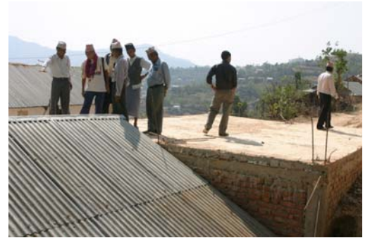
建替え予定の校舎の屋根の状態を上から調べる。
